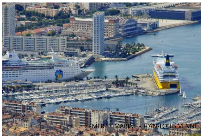
Le terminal ferries et croisière du centre-ville de Toulon.
